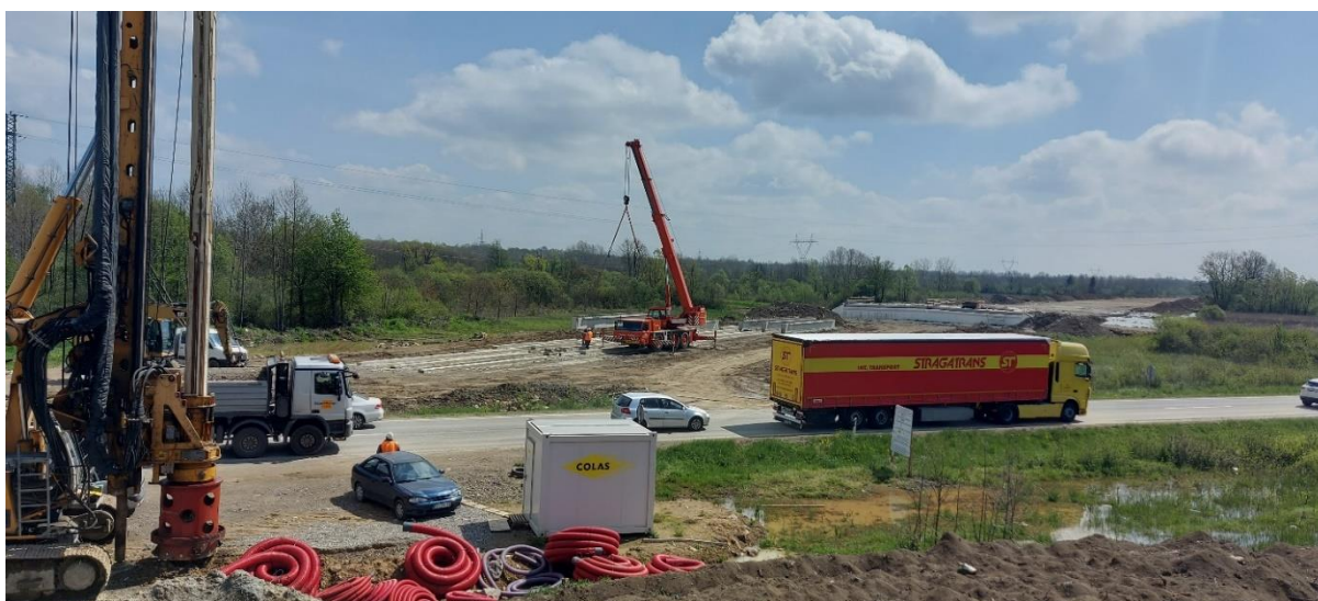
Slika 23. Gradilište u zoni nadvožnjaka Lekenik (vlastita fotografija, 2023)
