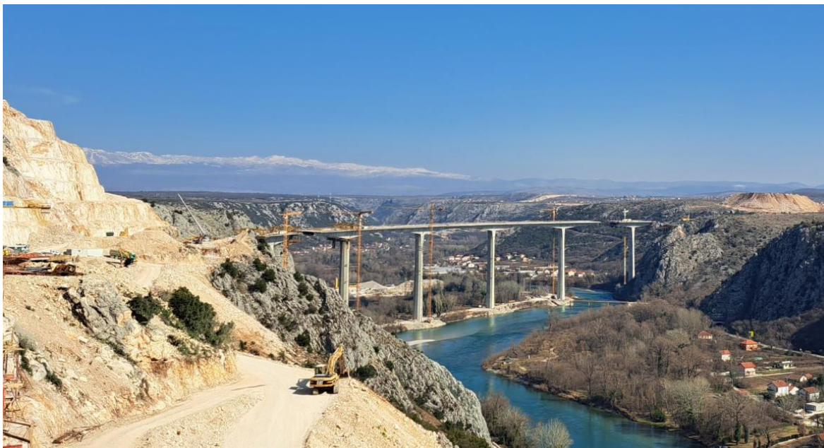
Slika 13. Gradilište mosta Počitelj (JP Autoceste FBiH d.o.o., 2022)
