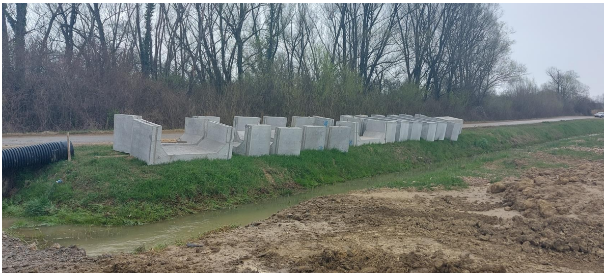
Slika 29. Predgotovljeni elementi propusta (vlastita fotografija, 2023)
