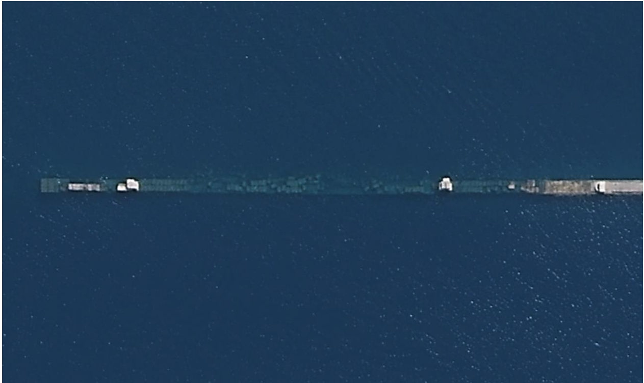
Slika 3. Oštećena dionica lukobrana Pula [2]
