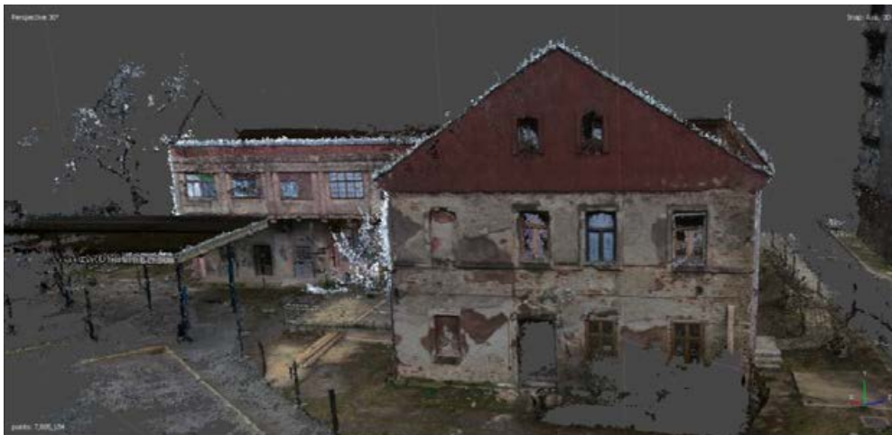
Slika 13 Dobra kvaliteta sjevernog pročelja
