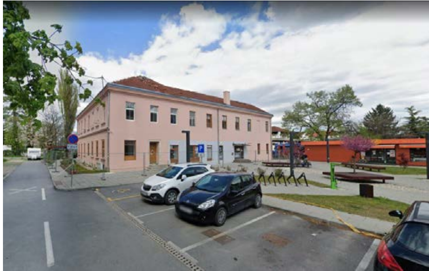
Slika 4 Južna strana objekta
