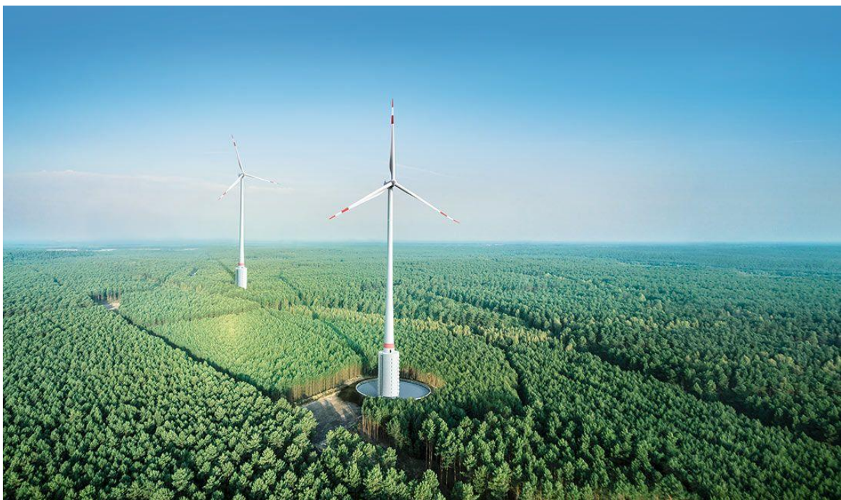
Slika 15. Dovršena vjetroturbina i puni rezervoar.
