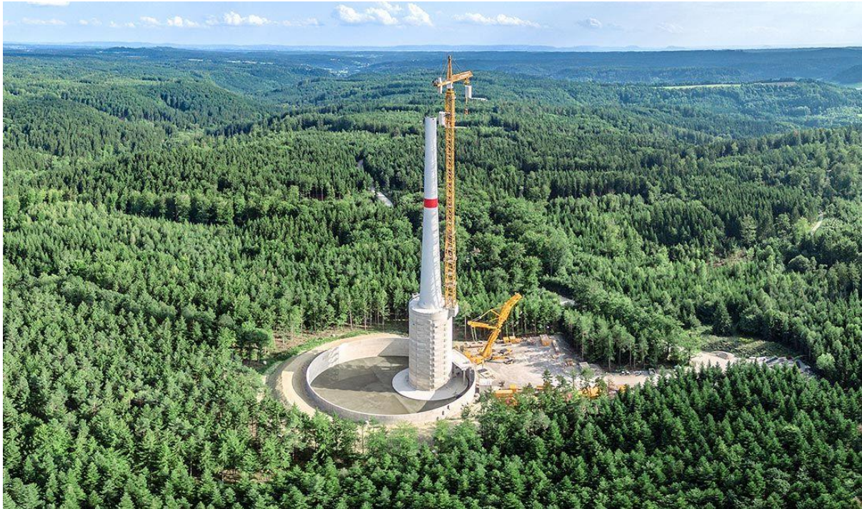
Slika 14. Izgradnja vjetroturbine i rezervoara.
