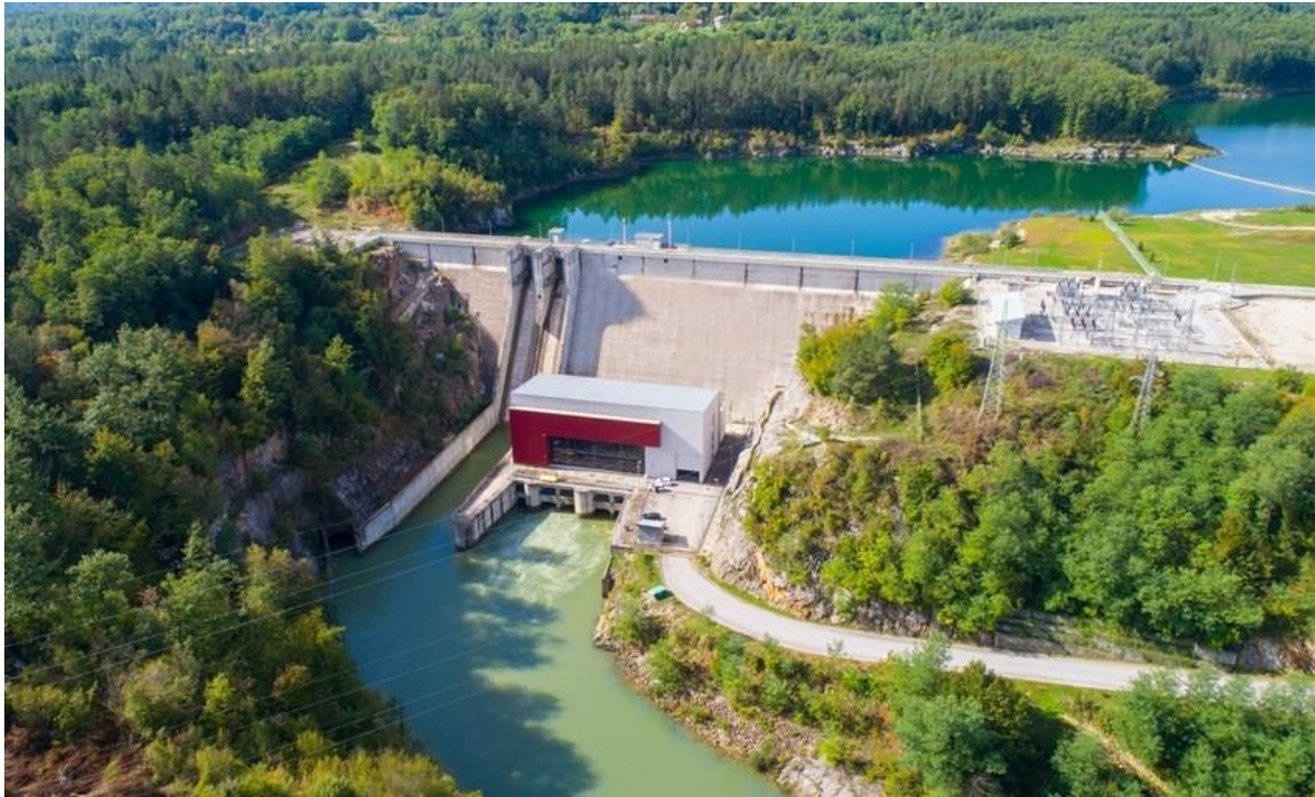
Slika 7. Betonska brana (Betonska brana HE Lešće).
