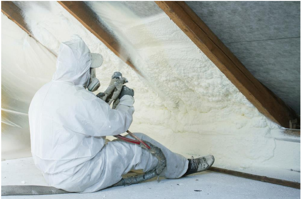
Slika 25. Izvedba izolacije poliuretanskom pjenom
