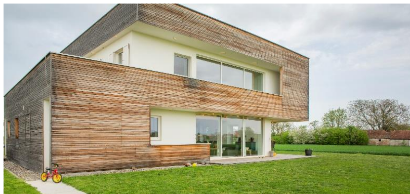
Slika 31. Južna strana kuće
