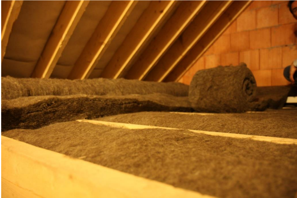
Slika 7. Izvedba izolacije ovčjom vunom
