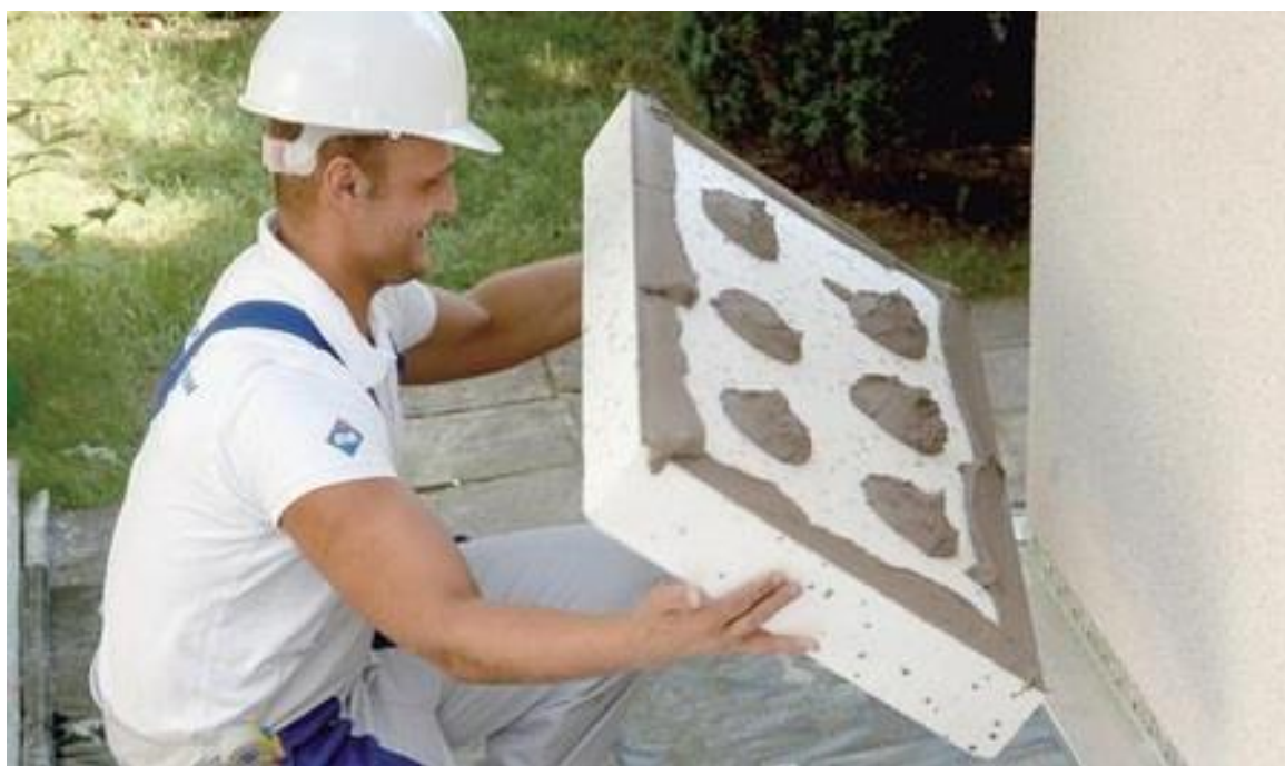
Slika 22. Lijepljenje stiropora
