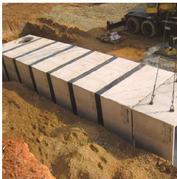
Slika 24. Spoj elemenata ljepljenjem
