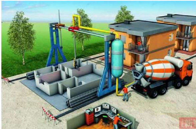
Slika 6. Proces printanja cijele zgrade
