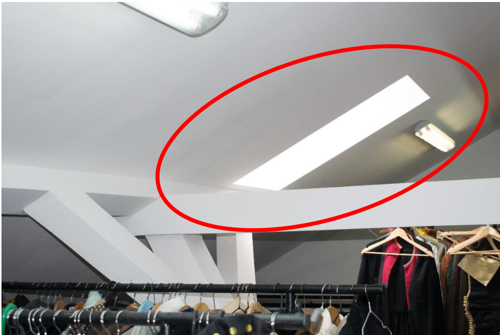
Slika 37 Dio krovišta koji je saniran
