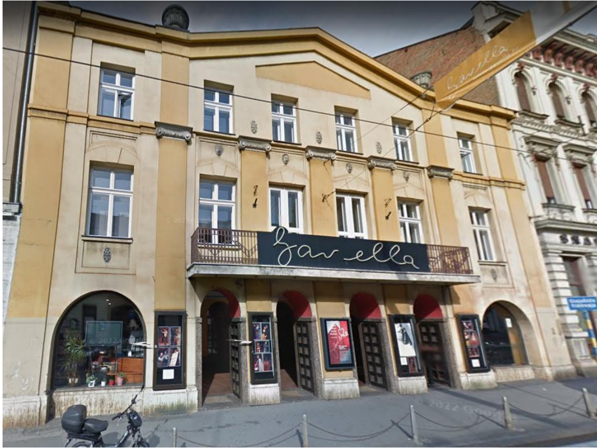
Slika 4 Pročelje prije potresa
