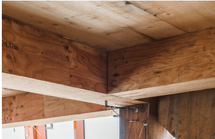
Slika 4 Detalj spoja sa senzorom za pomak
