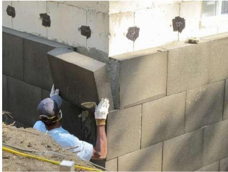
Slika 19. Izolacija fasade staklenom pjenom
