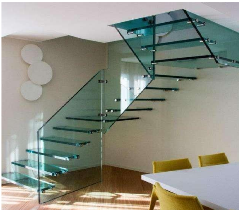
Slika 17. Primjer izvedbe ograde i gazišta od stakla [14]
