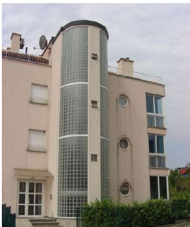
Slika 13. Dio pročelja stambene zgrade izveden od staklene opeke
