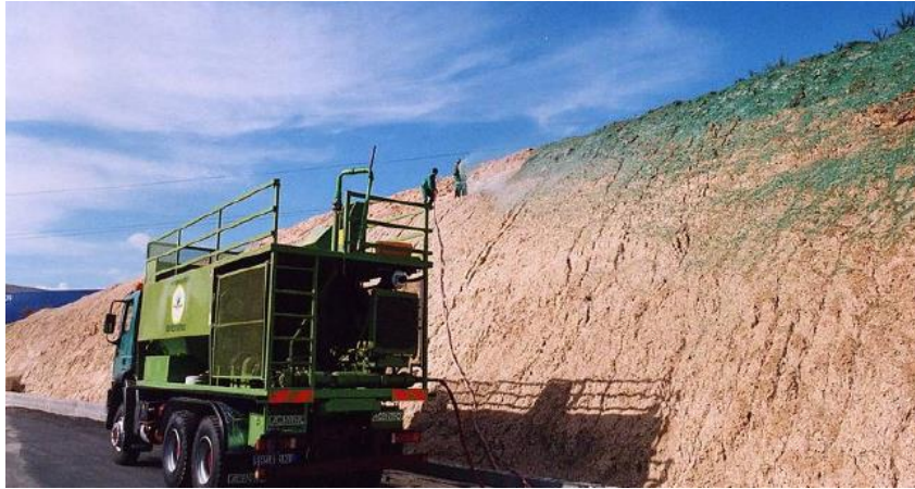
Slika 20-Hidrosjetva na strmom usjeku (6)
