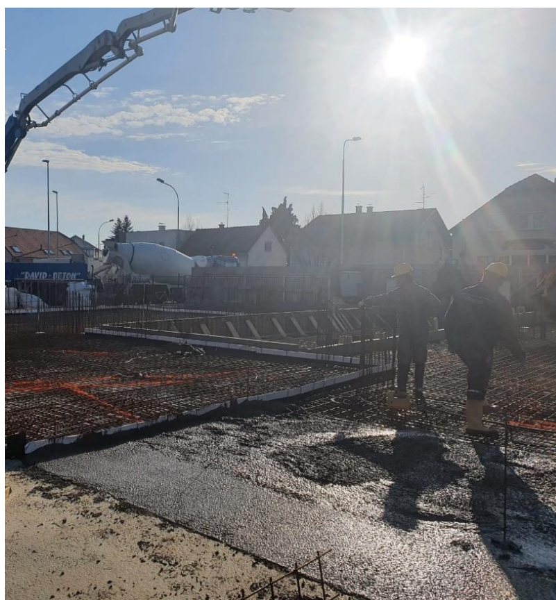
Slika 41. Betoniranje drugog dijela stropne ploče podruma
