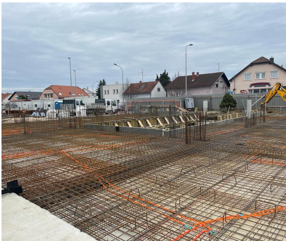
Slika 38. Postavljanje armature stropne ploče podruma (3/3)
