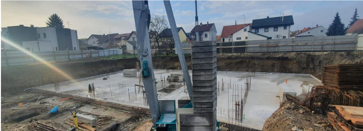
Slika 28. Izbetonirana temeljna ploča prvog dijela
