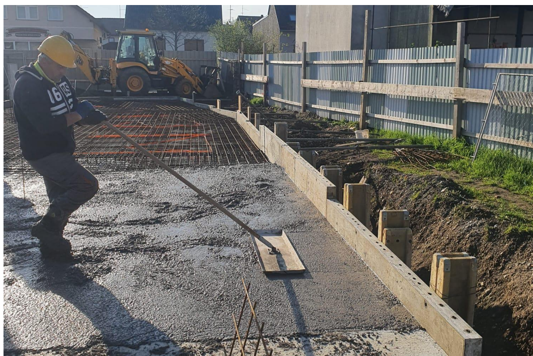
Slika 48. Ravnanje betona
