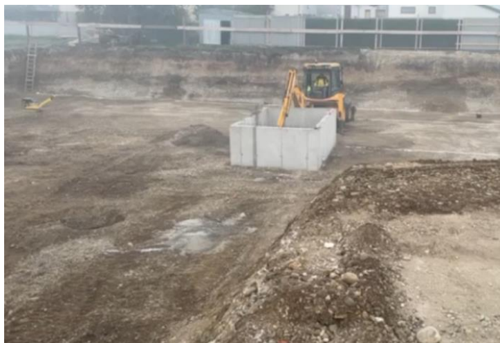
Slika 21. Kopanje unutar izbetoniranog okna dizala
