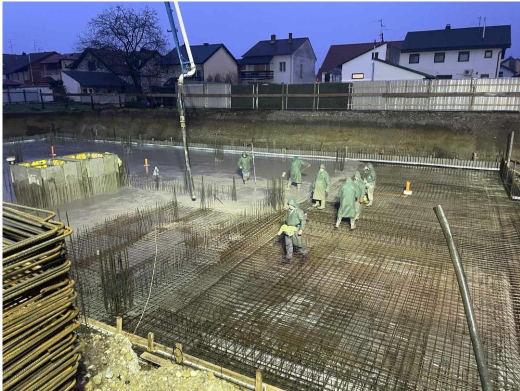
Slika 24. Betoniranje dijela temeljne ploče
