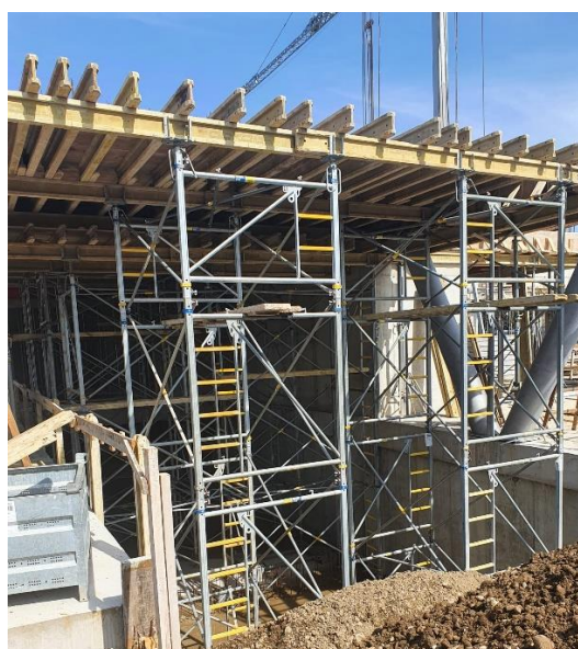
Slika 67. Stropna oplata Doka flex 1-2-4 proizvođača Doka
