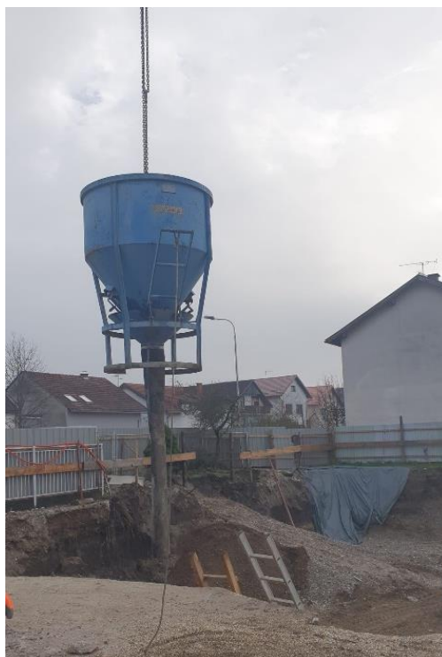
Slika 61. Kibla za betoniranje
