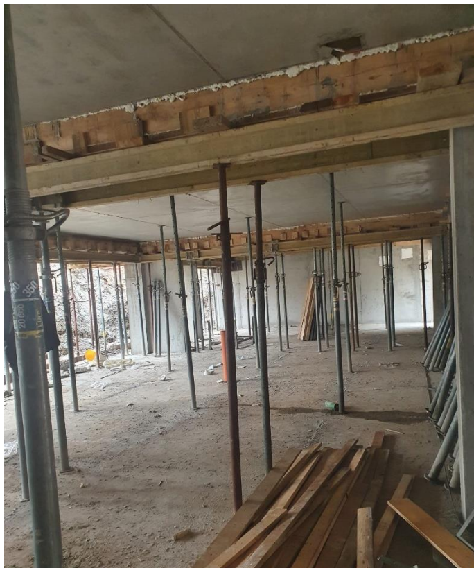
Slika 53. Skidanje stropne oplate na području podzemne garaže objekta – ostavljena oplata greda i podupirači
