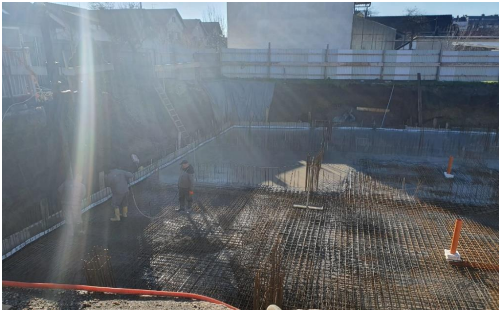
Slika 26. Betoniranje drugog dijela temeljne ploče ujutro
