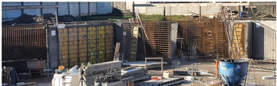
Slika 30. Oplata za vanjske zidove podzemne garaže
