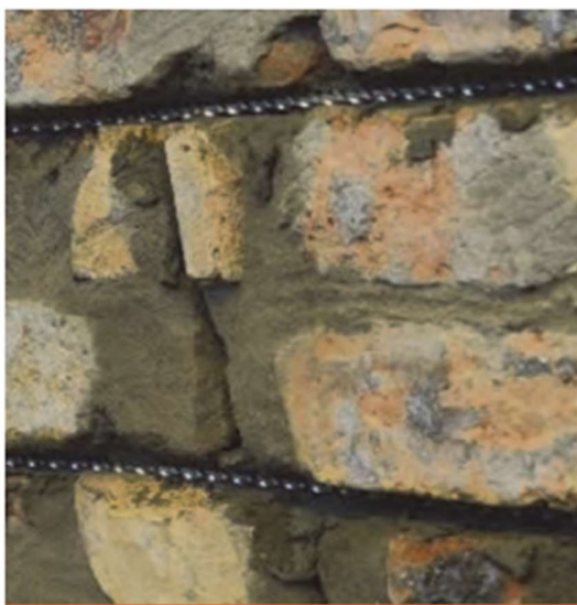
Slika 55. Umetanje čeličnih šipki (28)
