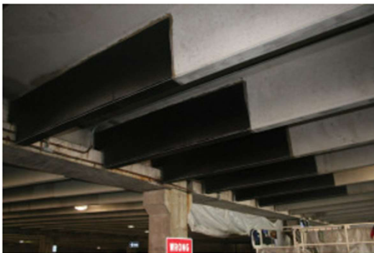
Slika 60. Ojačanje greda u jednoj garaži (36)
