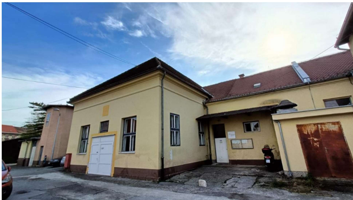
Slika 15. Prikaz sjeverozapadnog pročelja građevine
