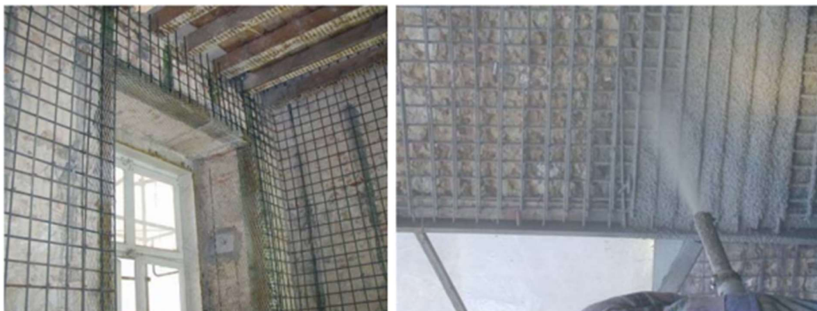
Slika 62. Armiranje obloge(lijevo), torkretiranje(desno) (32)
