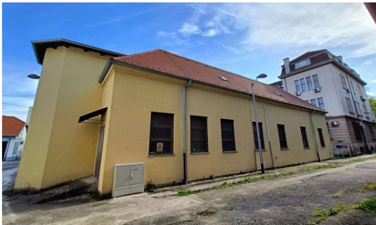
Slika 16. Prikaz jugoistočnog pročelja građevine
