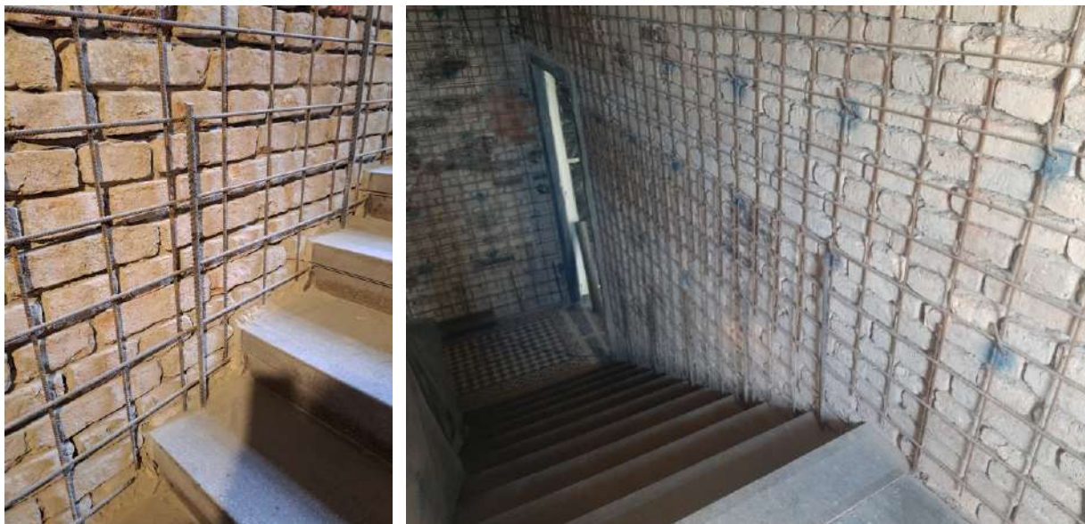
Slika 10 Armiranje zidova prije mlaznog betona
