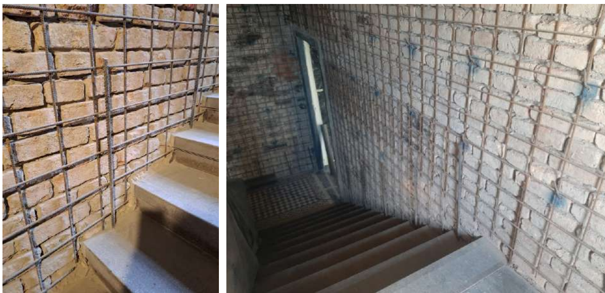
Slika 10 Armiranje zidova prije mlaznog betona
