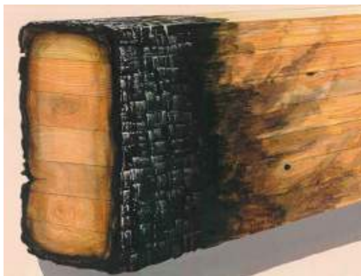
Slika 1.6 Drveni nosač izložen požaru [24]
