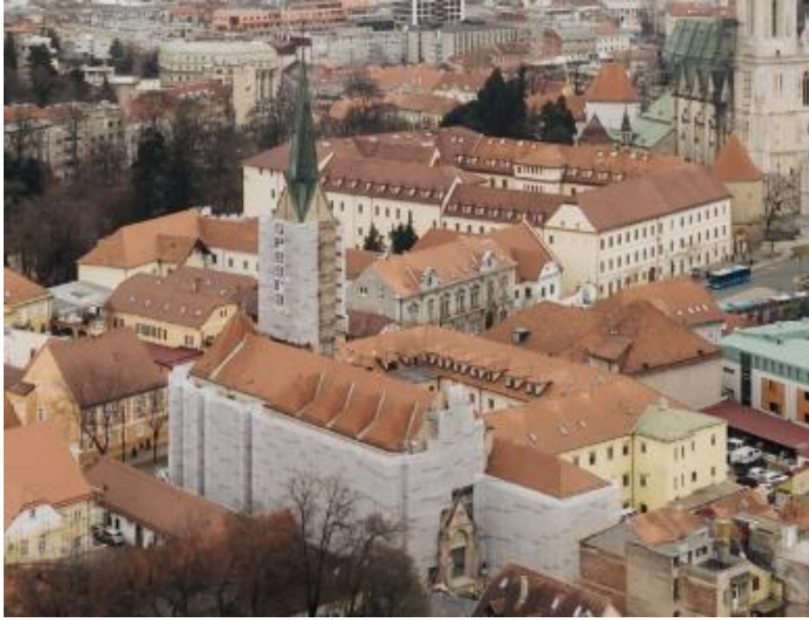
Slika 32. Crkva sv. Franje i zvonik tijekom obnove (Foretić, 2021)
