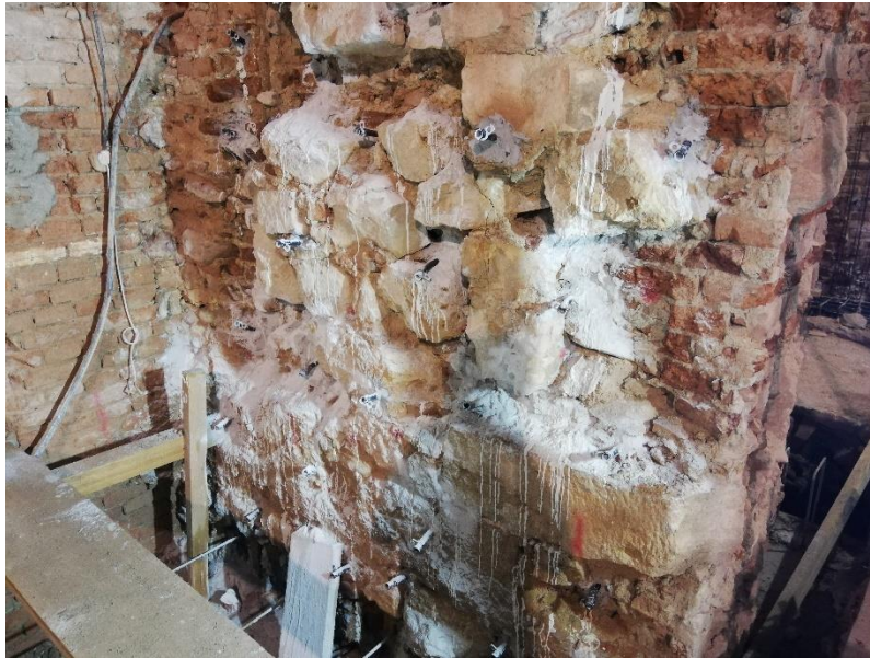
Slika 40. Zid kontrafora nakon injektiranja (Foretić, 2021)
