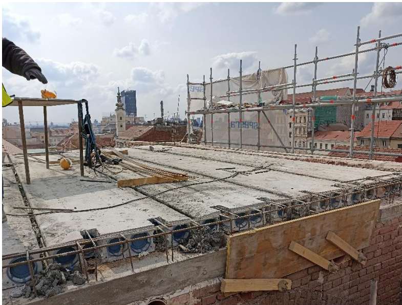
Slika 51. Izvedba predgotovljenih šupljih ploča (Foretić, 2021)
