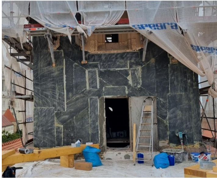
Slika 46. Ugradnja FRM tkanina na vanjskom zidu zvonika (Foretić, 2021)
