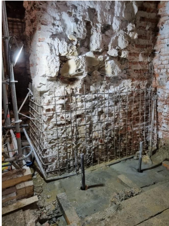
Slika 34. Ugrađena geotehničkih sidara (Foretić, 2021)
