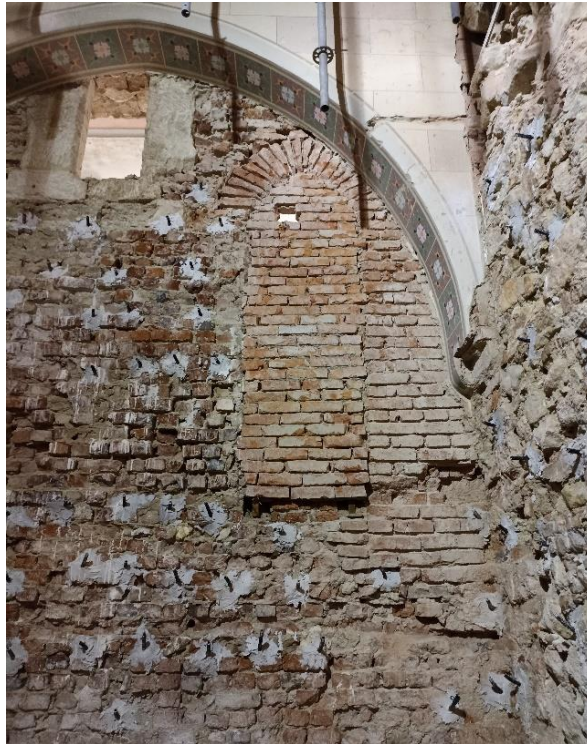
Slika 41. Injektiranje na južnom zidu crkve (Foretić, 2021)
