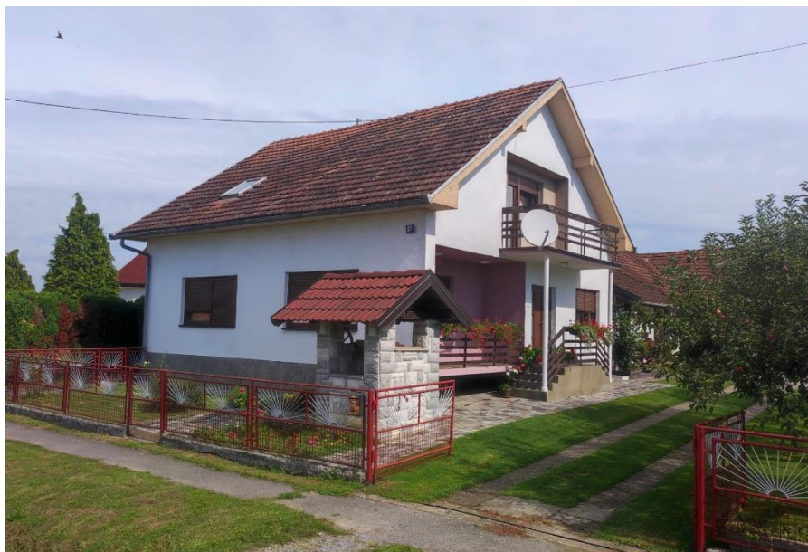
Slika 3.1. Pogled s južne strane zgrade
