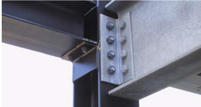
Slika 16. Vijčani spoj grede i stupa[2]
