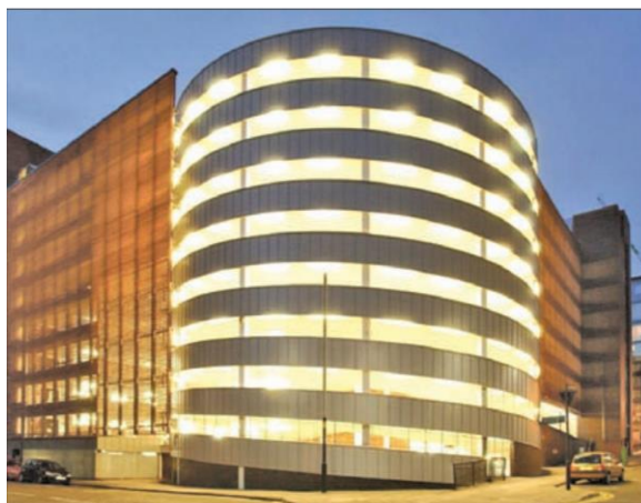
Slika 1. Garaža s vanjskom rampom zakrivljenog oblika [1]
