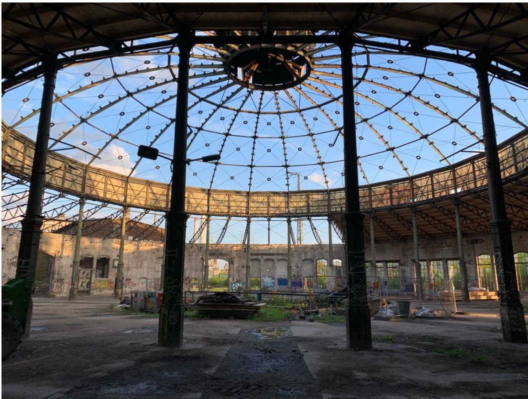
Slika 5: Rundlokschuppen Rummelsburg, primjer Schwedlerove kupole [10]
