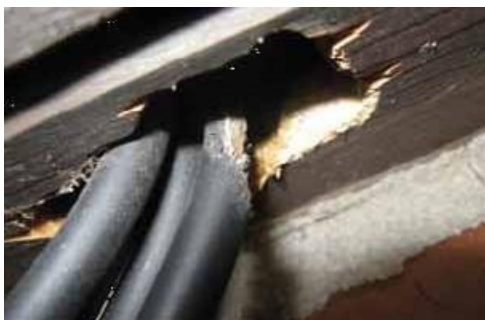
Slika 17 Oštećenje vodova (31)
