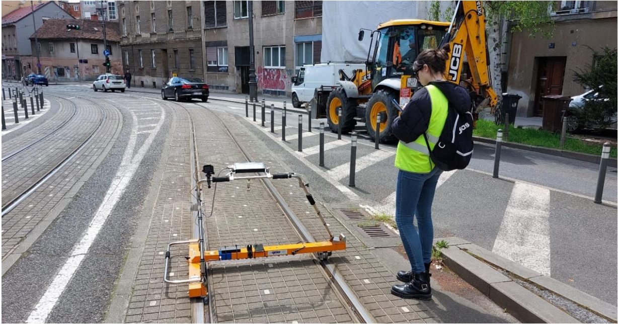
Slika 18. Mjerenje geometrije TEC-1000 ručnim kolicima
