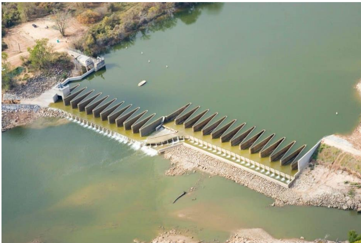
Slika 5. Labirintski preljev[5]
