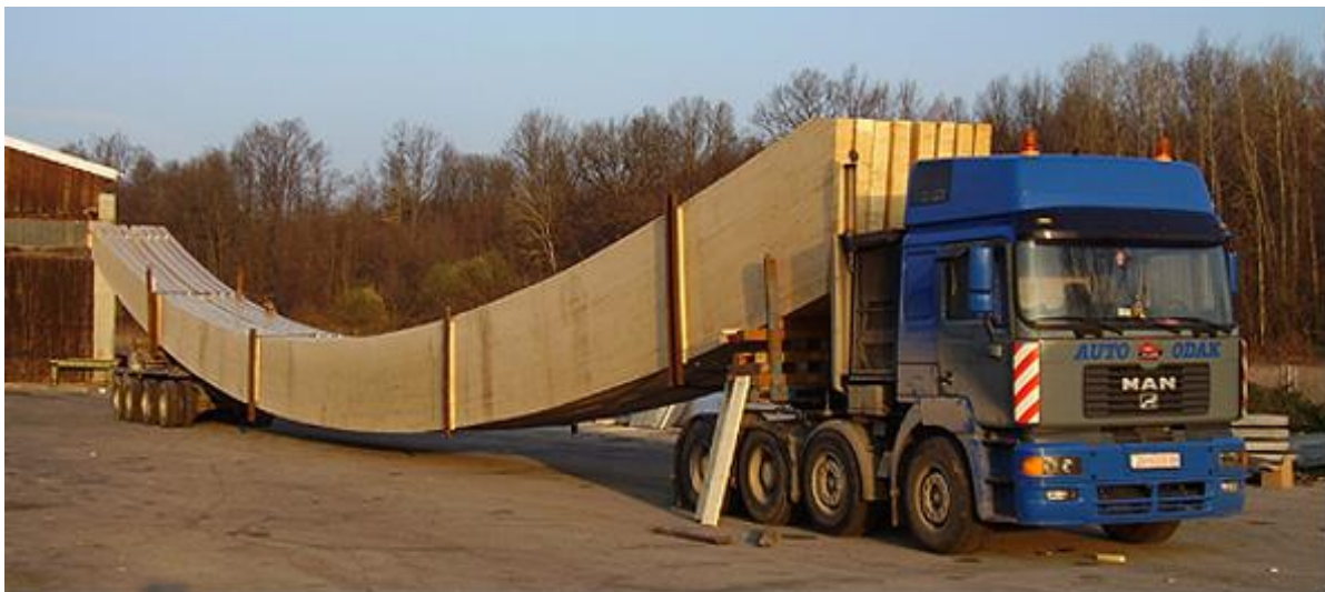
Slika 51. Primjer načina transporta lukova od LLD-a
