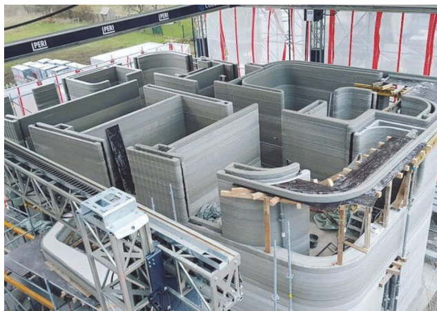
Slika 8. 3D pisač ispisuje trokutnicu (vanjske i unutarnje zidove) [33]
