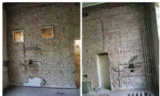
Slika 25. Karakteristični zidovi s otvorima i instalacijama
