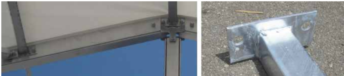
Slika 15. Čelični sekundarni nosač
