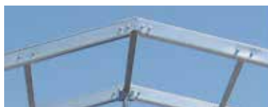
Slika 13. Priključak prečka - prečka s čeličnim umetkom
