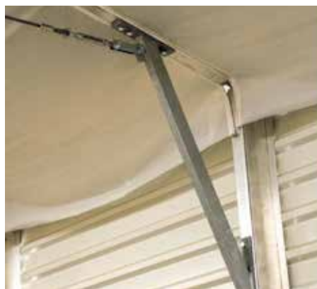
Slika 14. Priključak prečka-stup, varijanta s rukom i zategom
