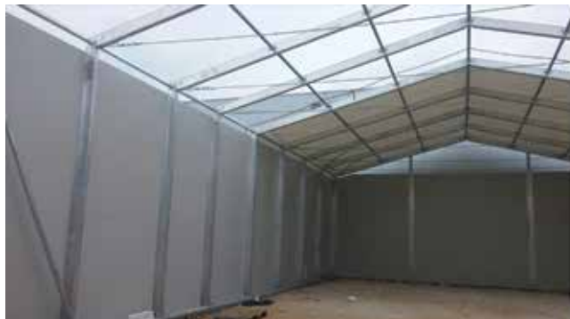
Slika 21. Montaža obloga i vrata
