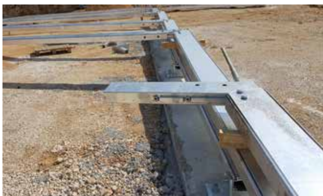
Slika 18. Okrupnjivanje okvira na tlu
