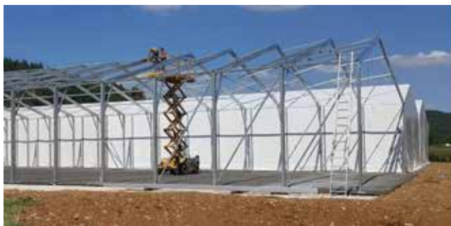
Slika 20. Montaža sekundarnih elemenata i stabilizacija
