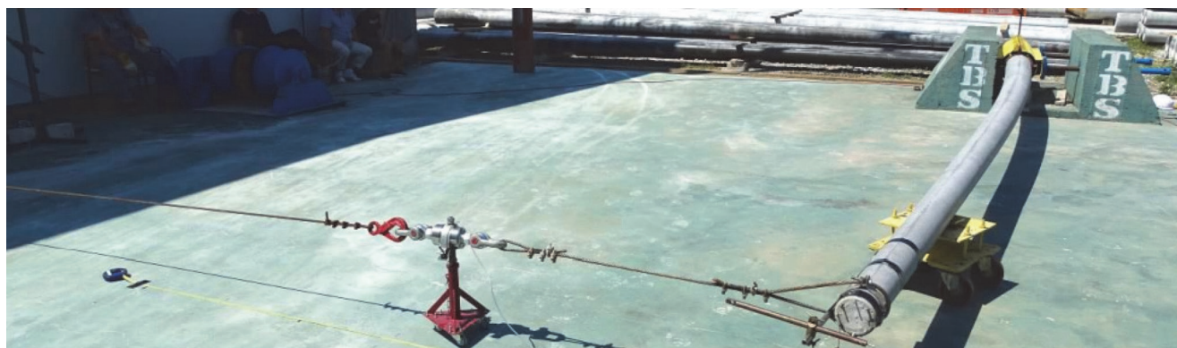
Slika 9. Provedba ispitivanja stupova
