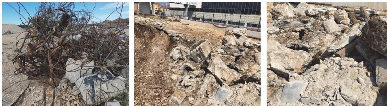
Slika 3. Otpad od rušenja postojeće građevine
