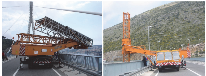
Slika 11. Pregled mosta Franje Tuđmana u Dubrovniku, 2005. godina [28]
