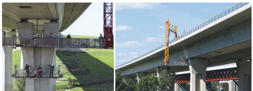
Slika 12. Primjeri specijalnih dizalica za pregled mostova [29]
