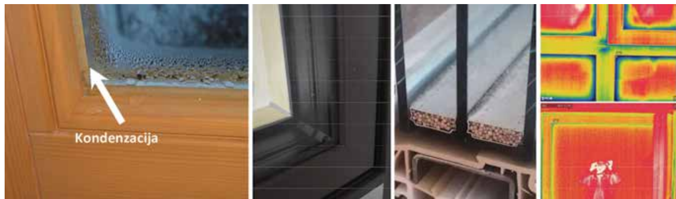
Slika 16. Kondenzacija vodene pare na rubu stakla (lijevo), kompozitni i aluminijски rub stakla (sredina), termogram toplinskog mosta na rubu stakla (desno)
