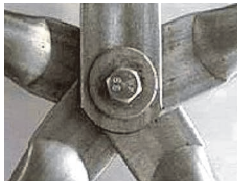
Slika 3. Neka rješenja čvorova čeličnih geodetskih kupola [5]
