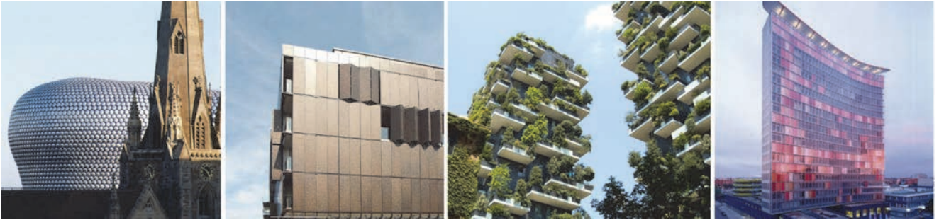
Slika 9. Suvremeni sustavi oblikovanja ovojnice - robna kuća Selfridge, Birmingham; stambena grada u Marthashof-u, Berlin; stambeni kompleks Porta nouva, Milano; poslovni toranj GSW, Berlin
