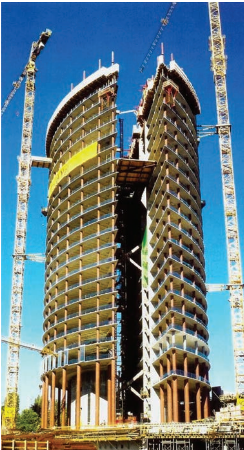
Slika 5. Posttower, Bonn: 42 etaže, N_{Ed,max} = 28\ 000\ \text{kN} Geilinger-Stützen® Ø 762mm - Ø 406mm
