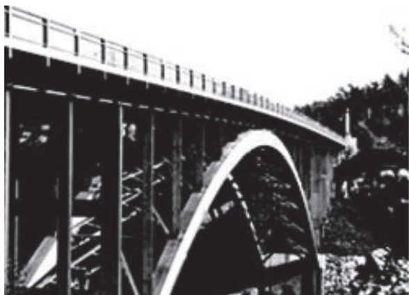
Slika 11. Most Arvida u Quebecu, Kanada
