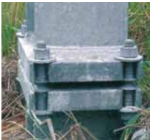
Slika 19. Primjer podnožja stupa koji otkazuje na posmik prilikom udara vozila [3]
