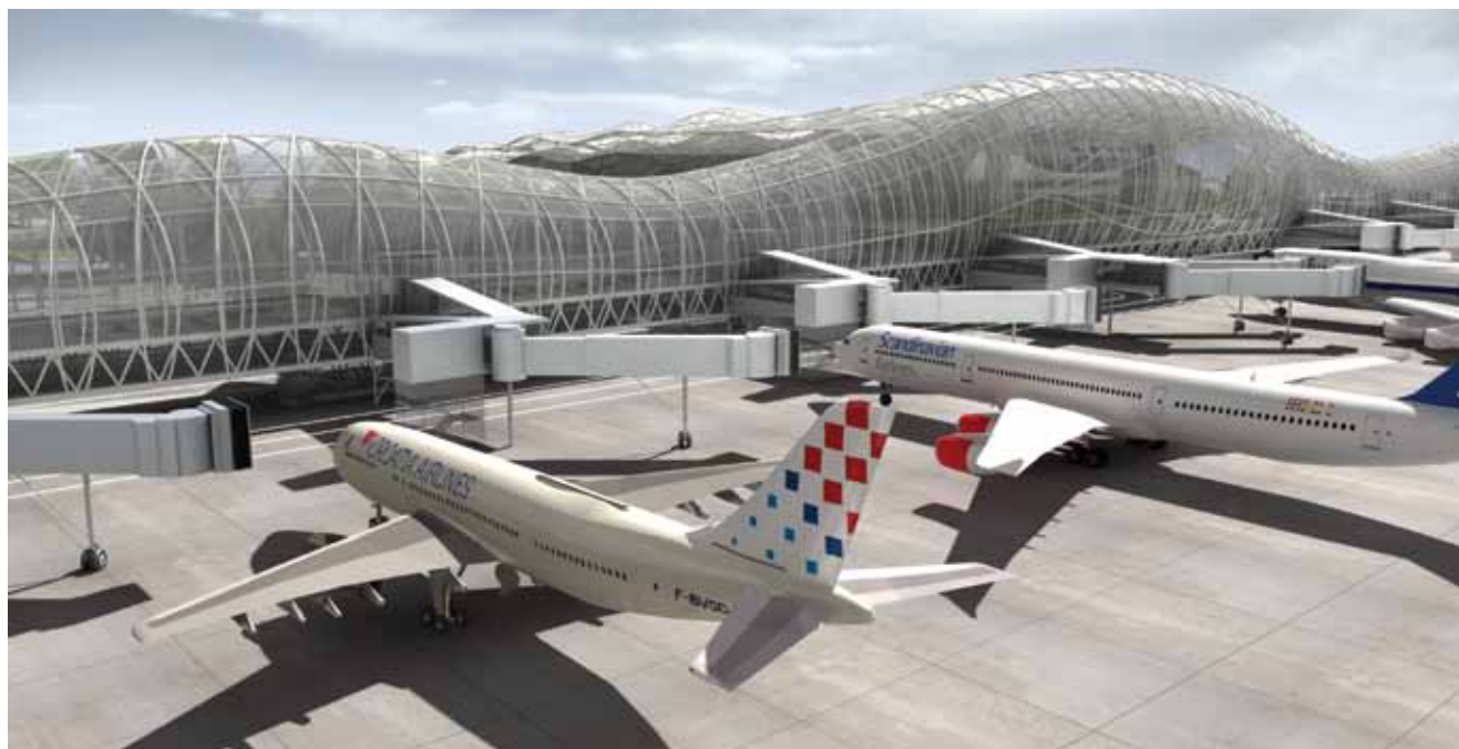
Slika 10. Sjeverni pogled s piste na zgradu terminala i pristupne rampe
