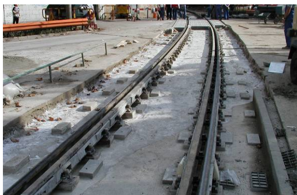
Slika 24. Izgradnja željezničkog kolosijeka u Rijeci (2002.)
