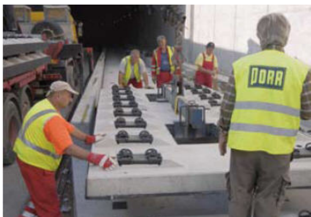
Slika 16. Montaža pločastog kolosijeka tipa "ÖBB-PORR"
