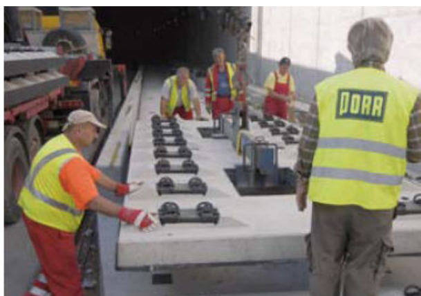
Slika 16. Montaža pločastog kolosijeka tipa "ÖBB-PORR"
