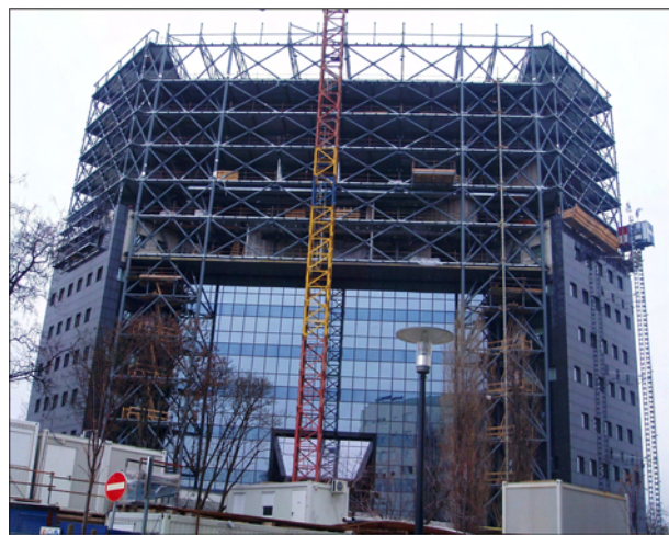
Slika 16. Dio nadogradnje sa samostalnim stupovima
