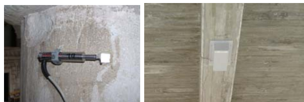
Slika 1. Postavljeni i zaštićeni LVDT za mjerenje deformacija
