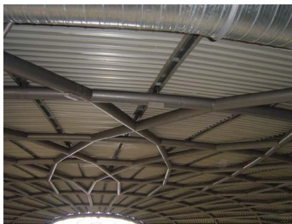
Slika 12. Dva zaštićena mjerna mjesta za mjerenje relativnih deformacija na čeličnom dijelu kupole
