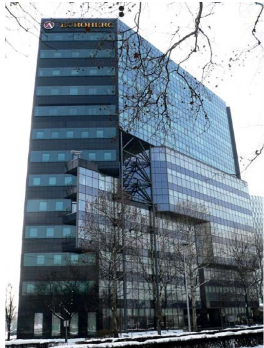
Slika 16. Poslovna zgrada Euroherc osiguranja nakon nadogradnje
