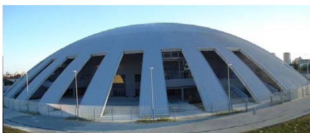
Slika 5. Kupola dvorane Višnjik, Zadar (2008.)
