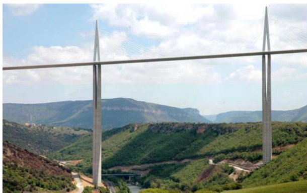
Slika 24. Viadukt Millau, dolina Tarn
