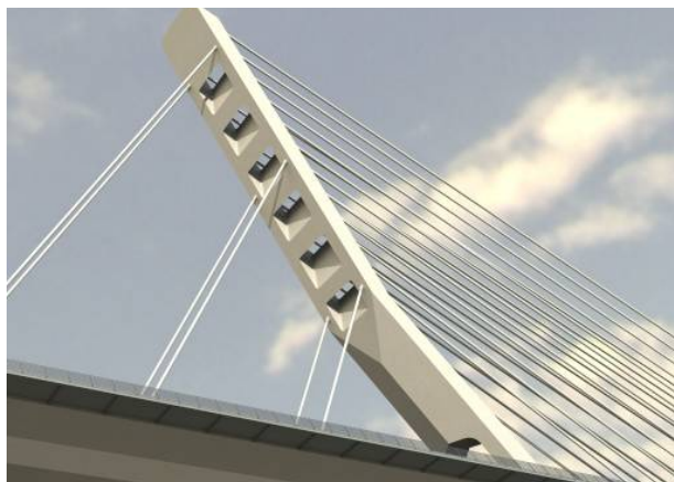
Slika 4. Pogled na pylon mosta Jarun
