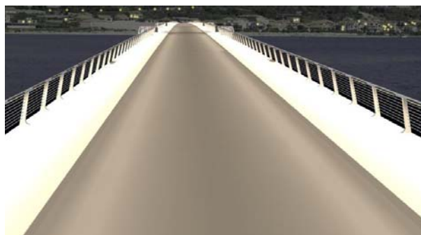
Slika 13. Rasvjeta prometnih ploha na mostu
