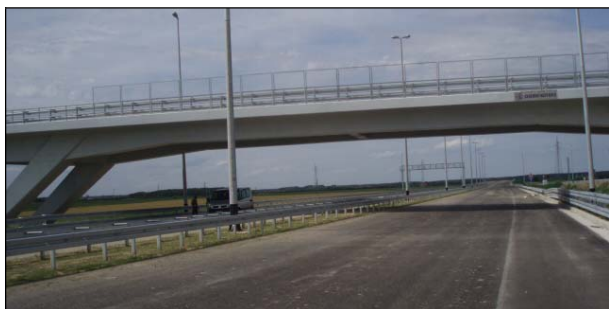
Slika 10. Nadvožnjak Osijek u čvoru Osijek
