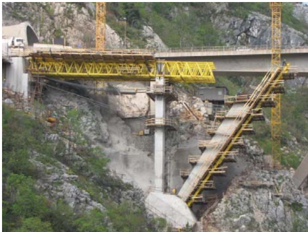
Slika 11. Privremeni betonski stup i skela za izvedbu zapadnog bočnog raspona i kosnika
