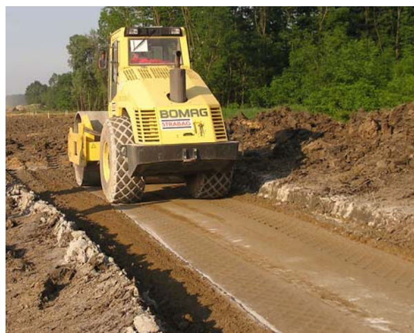
Slika 4. Zbijanje statičkim valjkom
