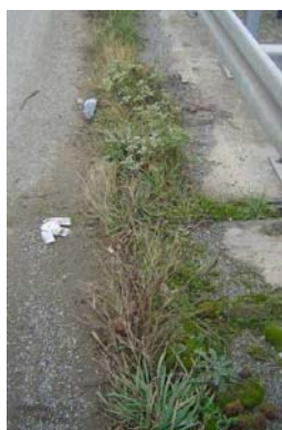
Slika 28. Korov i nečistoće na spoju kolnika s rubnjakom
