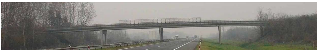
Slika 2. Pogled na jedan od pregledanih nadvožnjaka tipa DK
