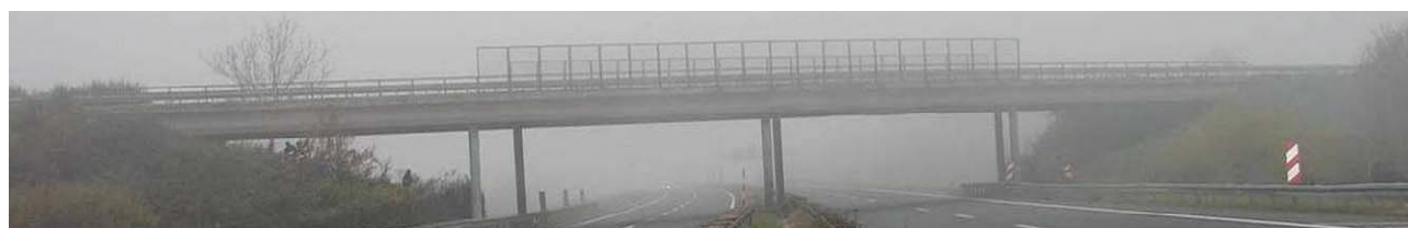
Slika 8. Pogled na pregledani nadvožnjak kod Popovače
