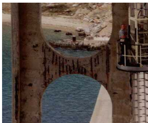
Slika 2. Stup S21: a) pukotine na stupu 1993.; b) odlamanja rubova pojasnice i širenje pukotina 2001.
