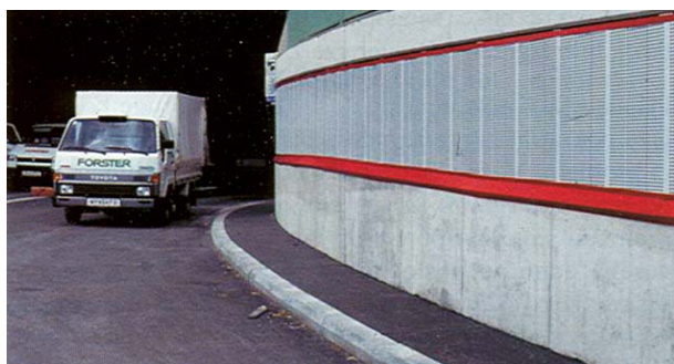
Slika 8. Oblaganje zidova podvožnjaka apsorberajućim panelima [19]
