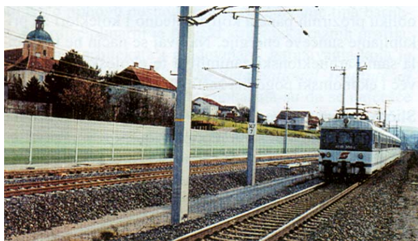
Slika 10. Zaštitna barijera na pruzi Neue HL-Strecke Westbahn, Austrija [19]
