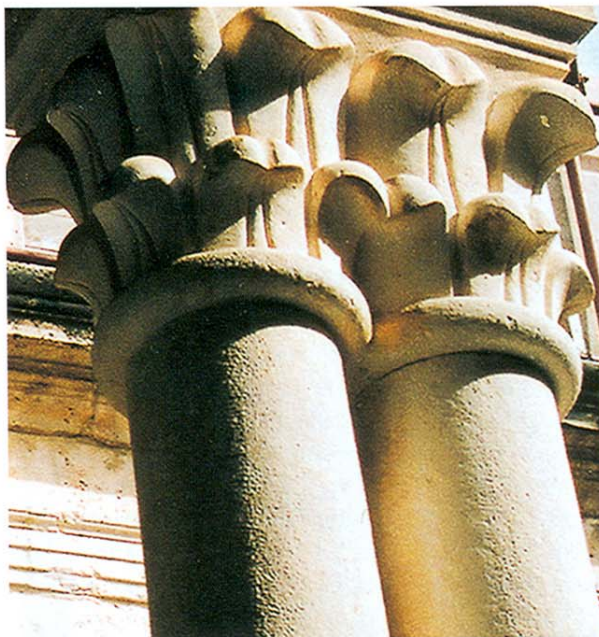
Slika 14. Precizna klesarska izvedba spojeva pri kapitelu jednog para stupova
