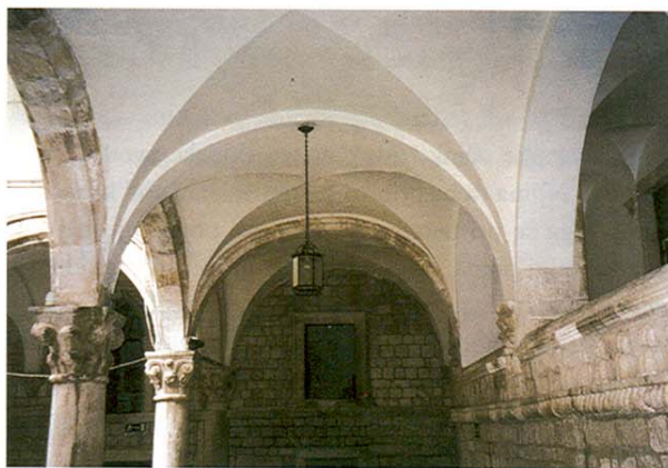
Slika 5. Svodovi prizemlja na južnoj strani atrija
