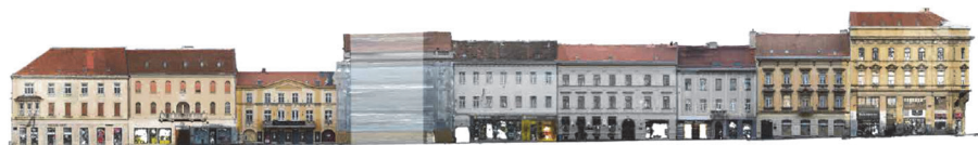
Slika 5. Frankopanska ulica: prikaz pročelja zgrada u nizu Bloka 19 [2]
