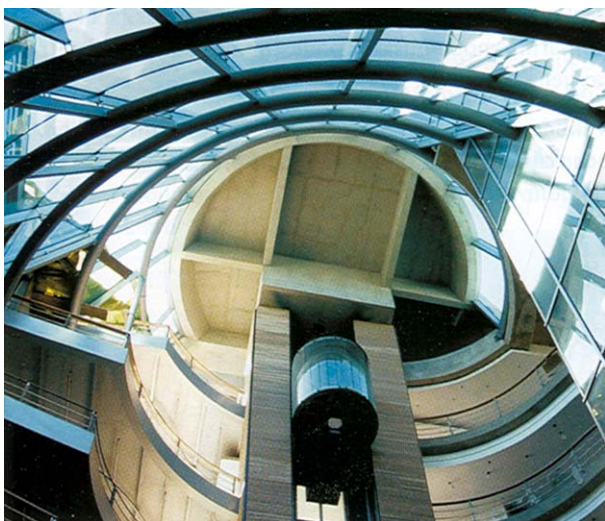
Slika 16. Panoramsko dizalo, unutrašnjost atrija
