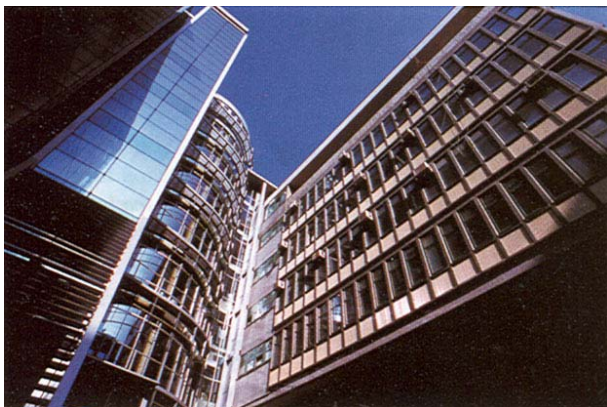
Slika 1. Spoj stare i nove zgrade
