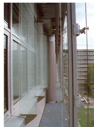
Slika 4. Prikaz dvostrukoga pročelja iznutra
