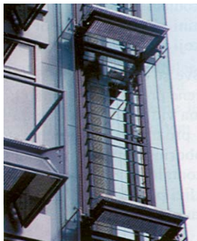
Slika 10. Detalj pokretnih krilaca dvostrukog pročelja
